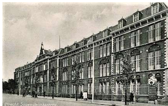
Utrecht, Sijpensteijnkazerne. Figuur 148 Locatie 896 Hoofdveldpostkantoor
